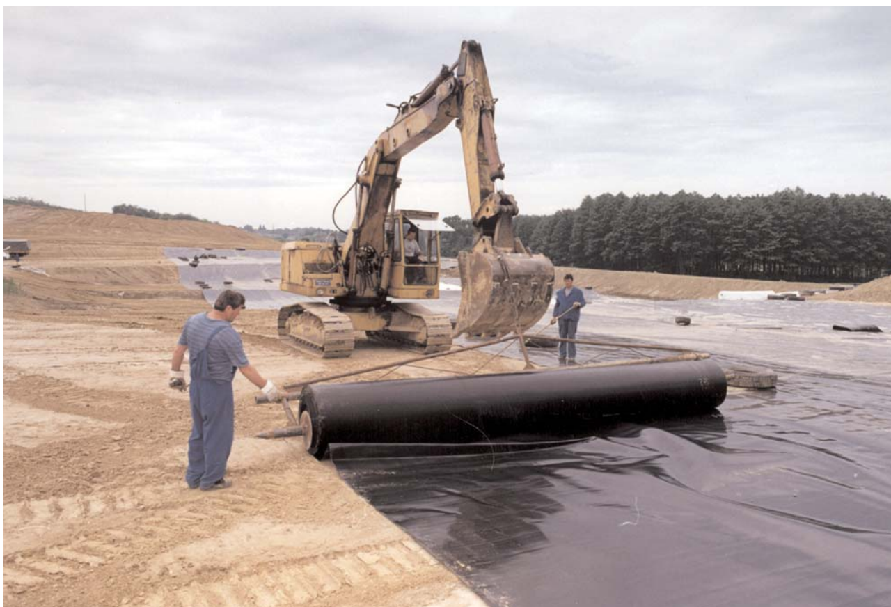
Izgradnja moderne deponije otpada.
